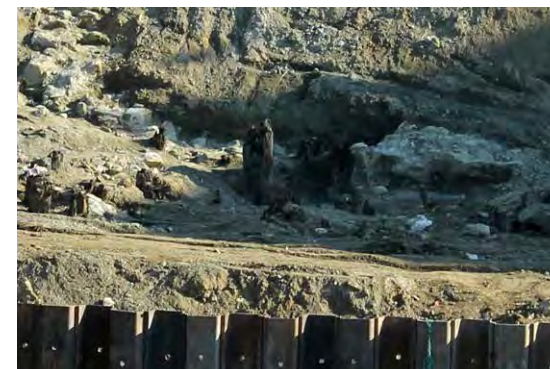
Základy pilíře na pravém břehu
