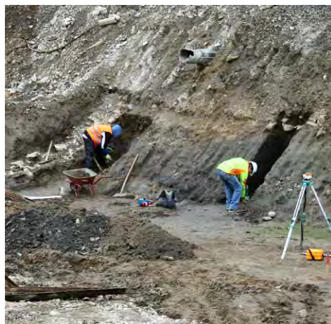
Sondy u základů bremy mostu
